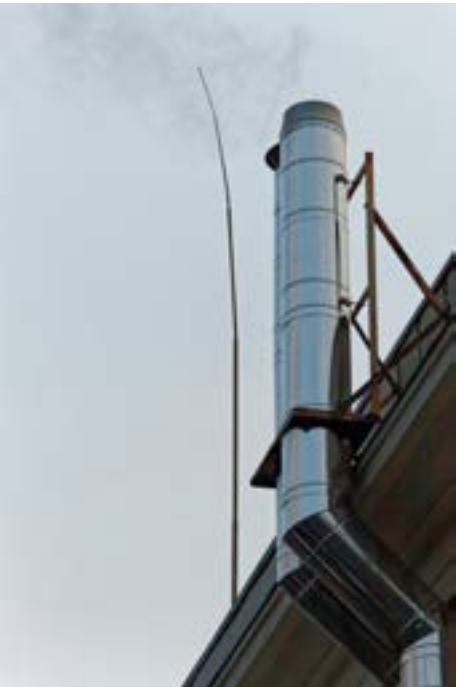
Рис. 2.4.2 - Остаточная деформация (изгиб) молниеприемника
