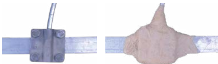
Рис. 2.10.4 – Защита места соединения (бандаж) антикоррозионной лентой PLP
